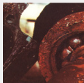
ベアリング損傷
