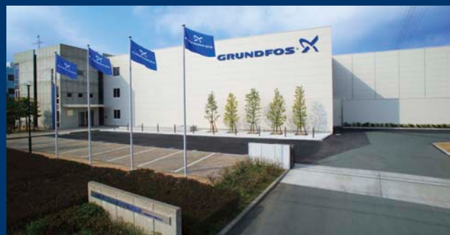
▶ 浜松本社・工場
