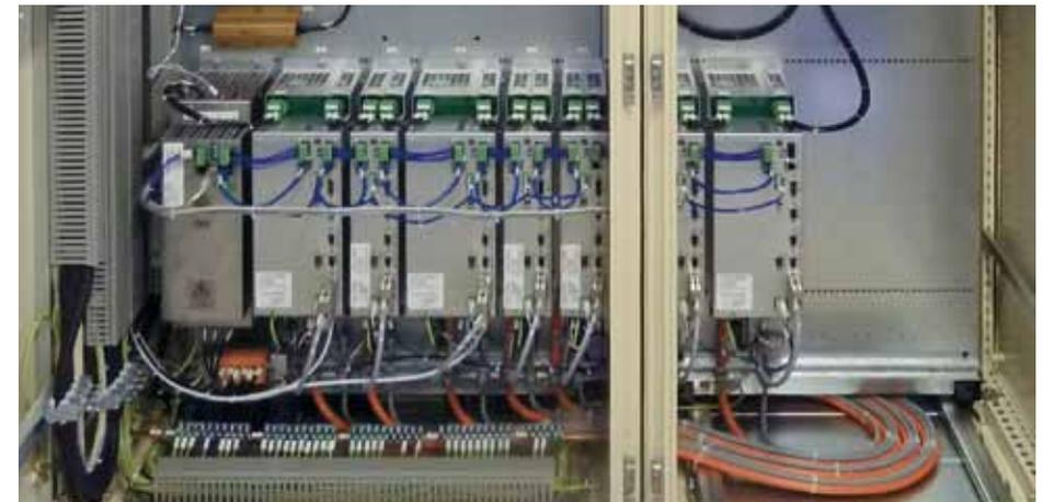
SD2はDC電圧接続を行うことで、多軸プレスシステム等において利点があり多くのマシンでご使用いただいております。プレス工程をきわめてダイナミックに、エネルギー効率よく行うことができます。
