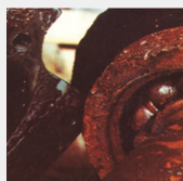
ベアリング損傷
