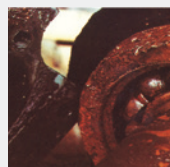
ベアリング損傷
